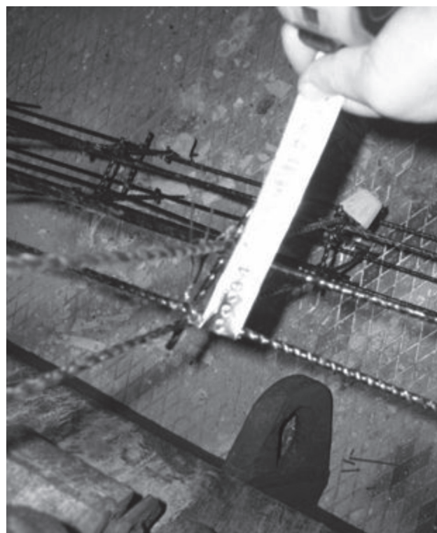
Рисунок 6.3 – Фрагменты арматурных каркасов из базальтопластиковых стержней, уложенных в опалубочную форму дорожной плиты с контролем их геометрических параметров
