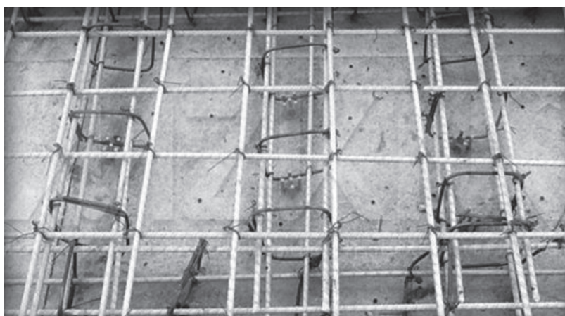
Рисунок 4.3 – Объемный каркас из АНК
