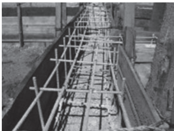
Рисунок 8.6 – Армирование фундамента по периметру сооружения
